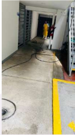
Imagen 9. Mantenimiento de alcantarillado interno sede principal
